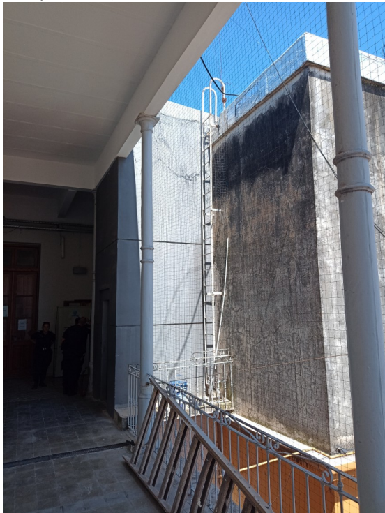
Vista escalera marinera (se aprecia la red anti-palomas)
