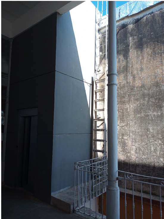
Vista hacia escalera marinera existente
