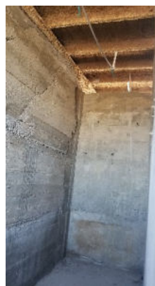
Demoler Viga de frente y rehacerla, con sus debidos apuntalamientos.
