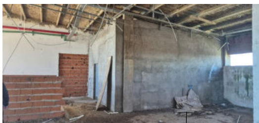
Demoler Tabiques de Hormigón Armado en Planta Alta.
