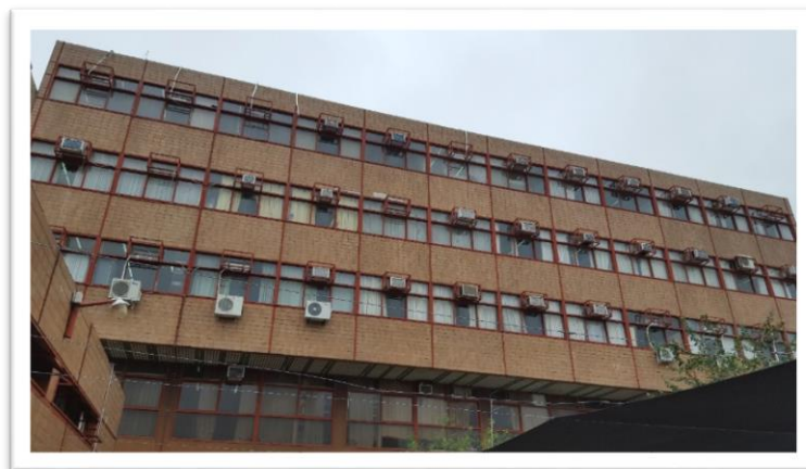
CONTRAFACHADA (Vista Sur).
