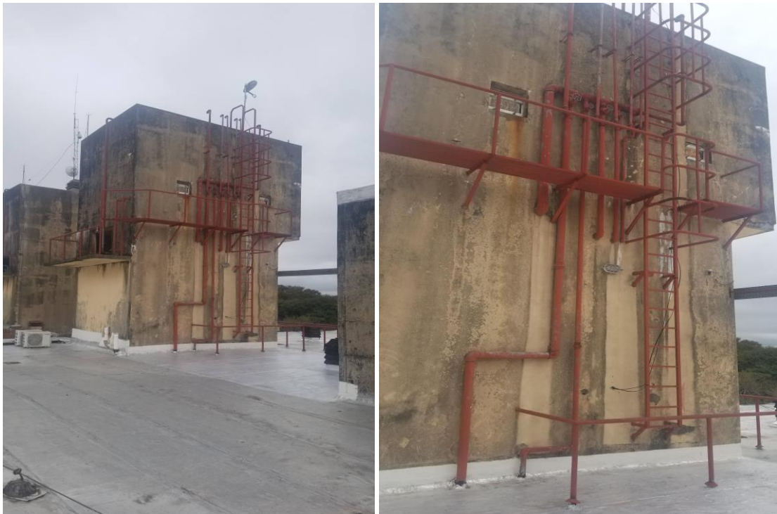
Figura 4. Imágenes de colector a readecuar.
