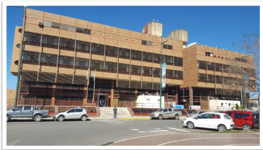
FACHADA PRINCIPAL PALACIO DE JUSTICIA, calle San Martín (Vista Norte)
